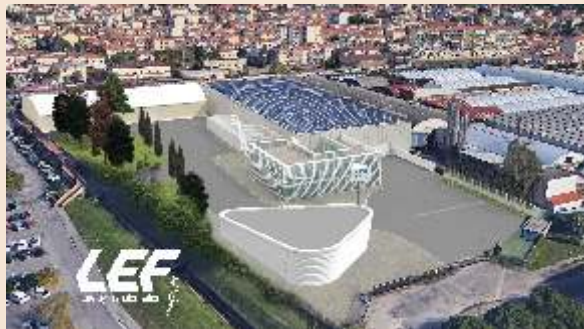
La nuova sede LEF Group a breve si sposterà nella nuova sede situata a Sesto Fiorentino (FI), dove verranno completamente riorganizzati tutti gli spazi per gli uffici e le produzioni
